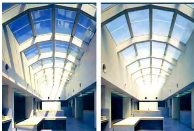
شکل ۱۲-۷۲- نمونه پوشش شفاف سقف با شیشه‌های فتوکرومیک
